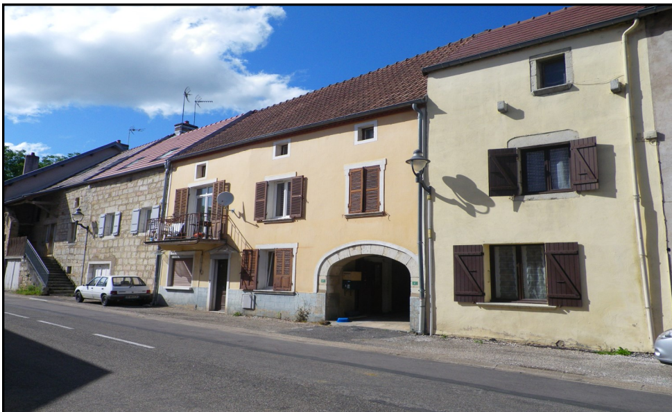
Vue d'ensemble des bâtiments (du n°6 au n°12) de la rue Casel, construits avec les pierres de l'ancien château de la rue du Truchot.
